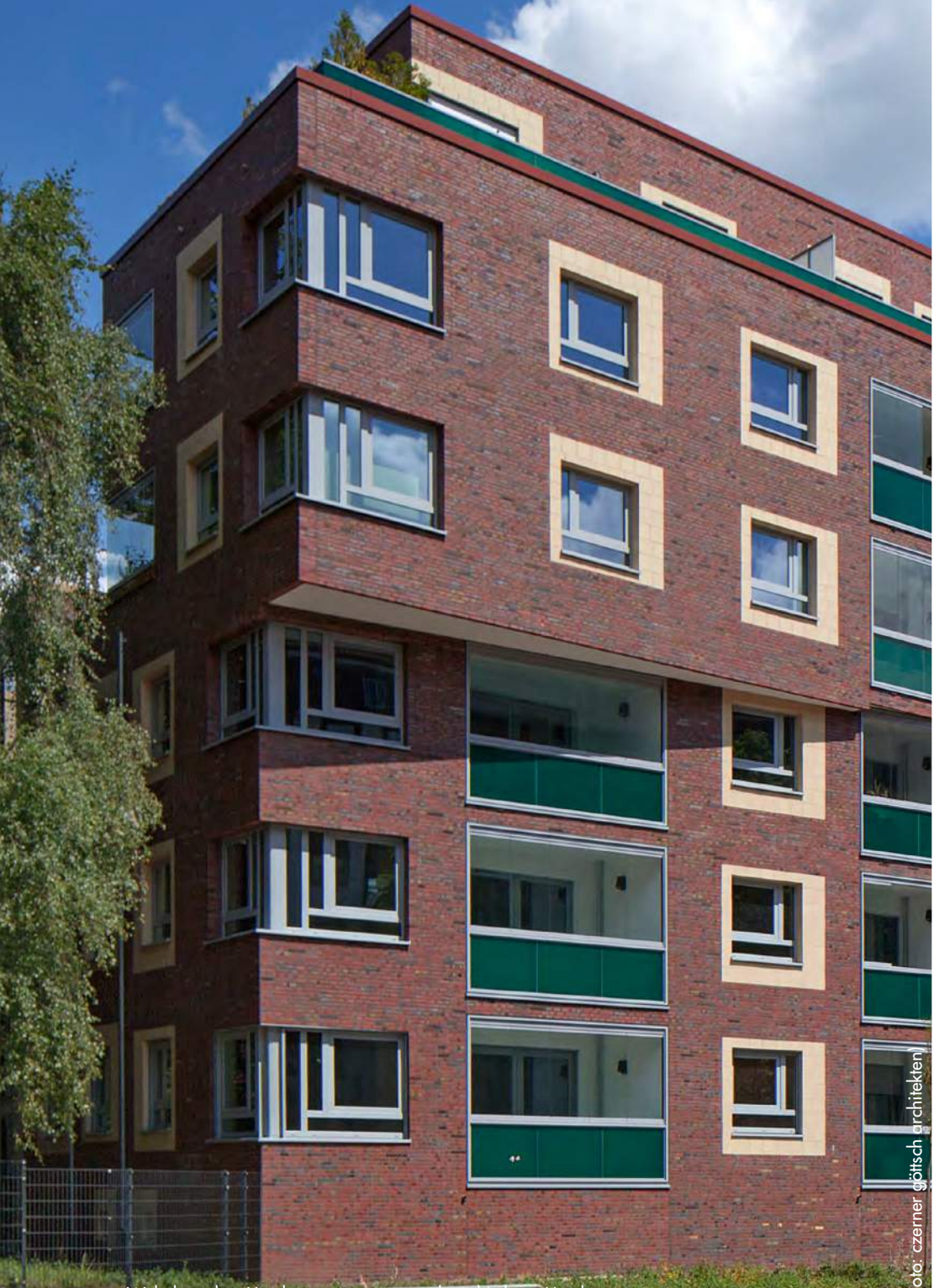
Wohnkomplex, Hamburg · czerner götsch architekten, Hamburg
